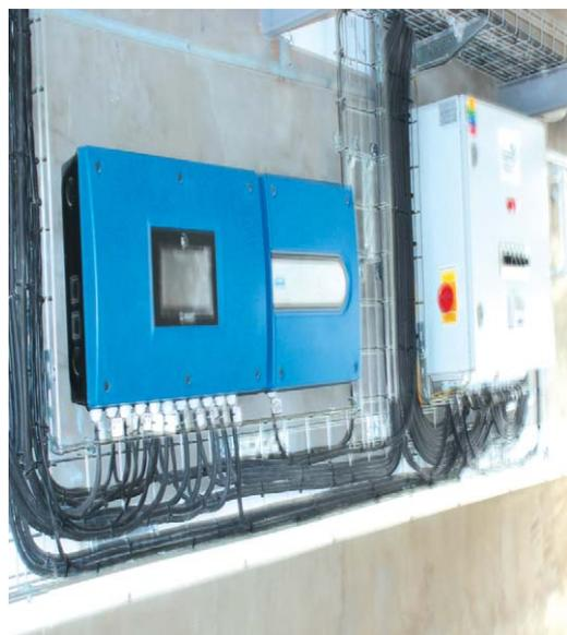
Оборудование контроля хранения и расходов кормов, поддержания микроклимата с передачей параметров в единую диспетчерскую компании
